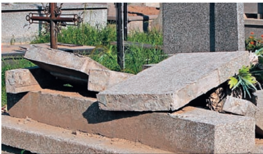
Brak prętów ze stali zbrojeniowej łączących poziomą płytę ze stojącymi elementami nagrobka
